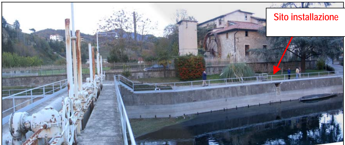
Foto 3 – Stazione di Sarnico diga regolatrice località Fosio;
