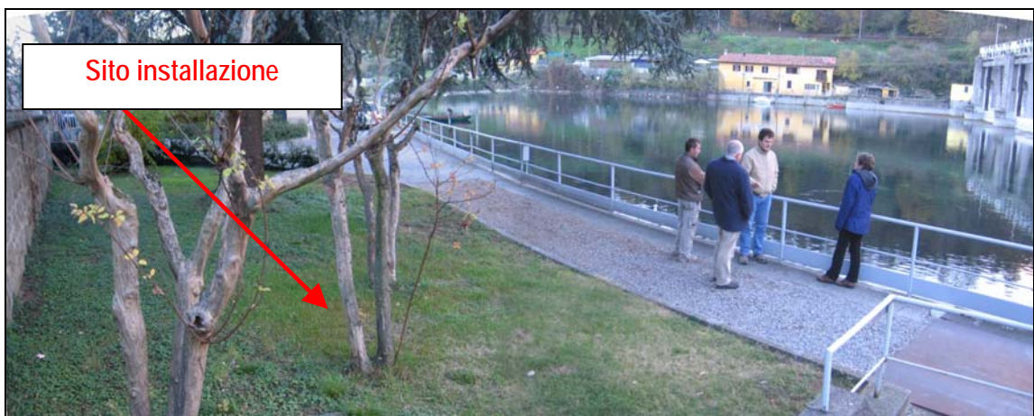
Foto 4 – Stazione di Sarnico diga regolatrice località Fosio;
