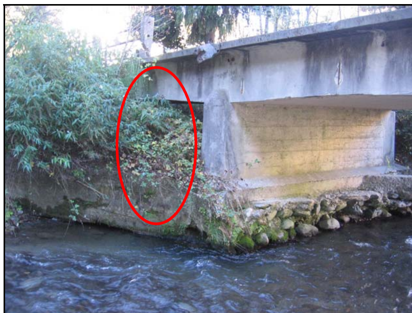
Foto 2 –Stazione di Sovere; cerchiato in rosso il punto d'installazione.
