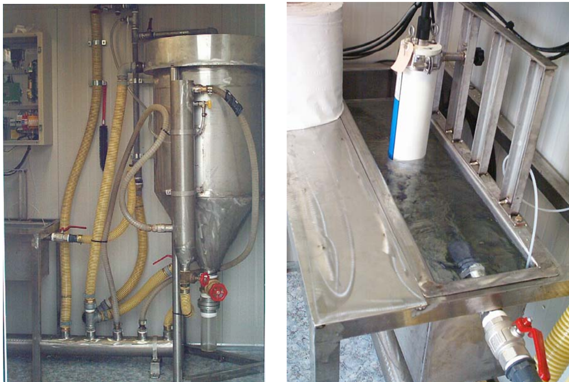
Figura 3 - Sedimentatore (a sin) e sonda multiparametrica installata su canaletta (a dx).
