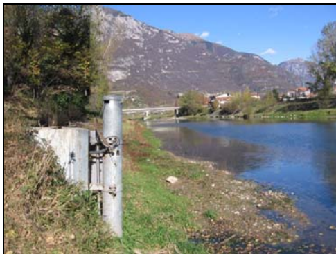
Foto 11 - Opera di presa (11/11/2007).
