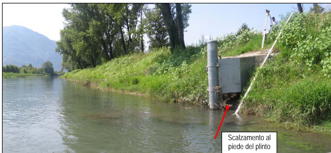
Foto 14 - Opera di presa (06/08/2009).
