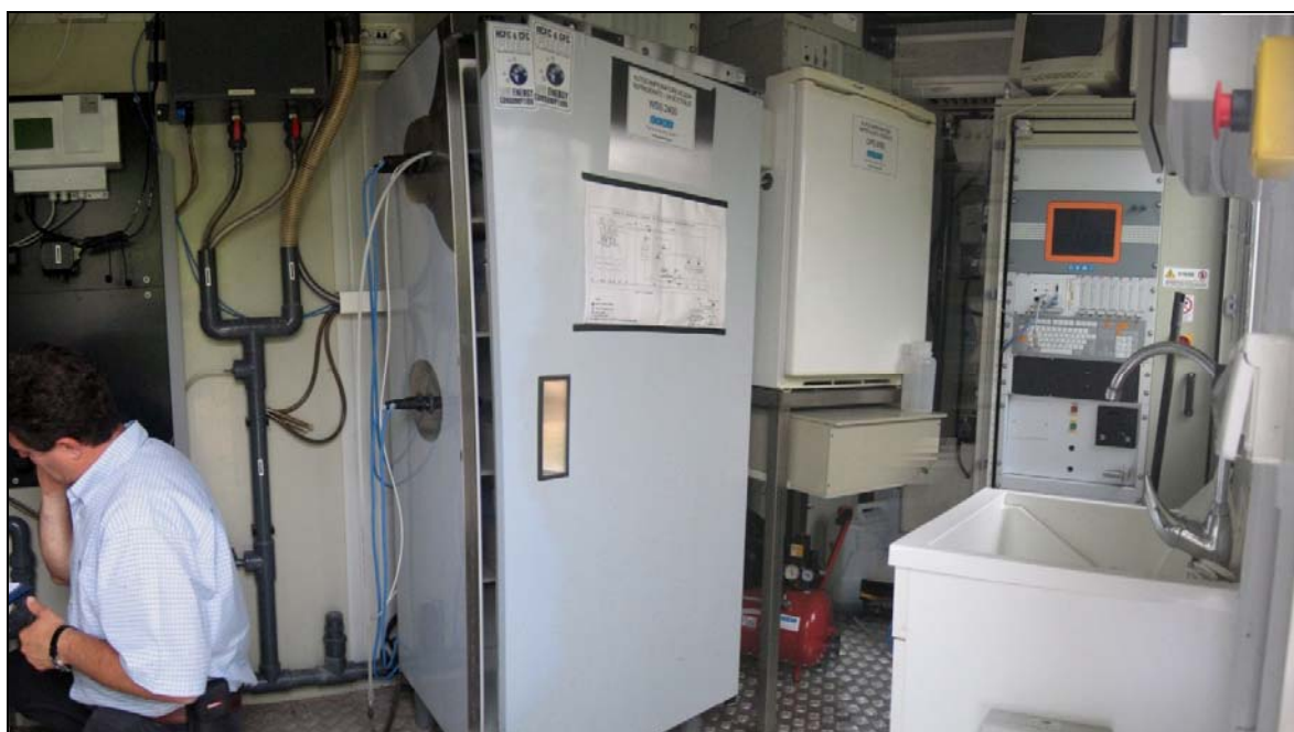
Foto 6 - Panoramica dell'interno della stazione di Costa Volpino (19 giugno 2009).
