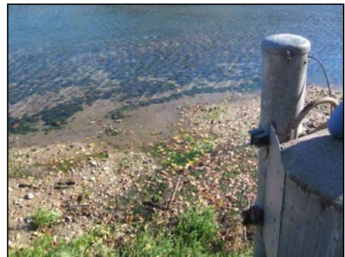
Foto 12 - Opera di presa (11/11/2007).
