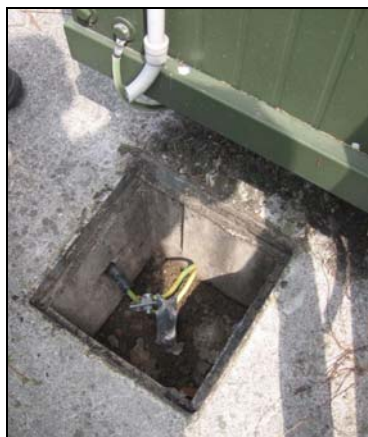
Foto 5 - Pozzetto realizzato nel basamento della stazione con scarico a terra dell'impianto elettrico.
