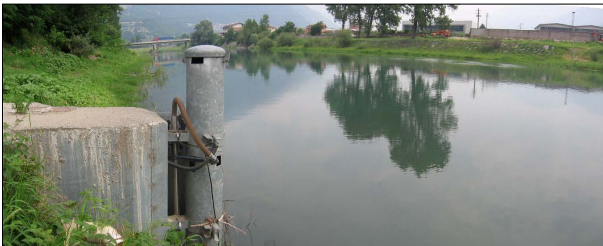
Foto 13 - Opera di presa (19/06/2009).
